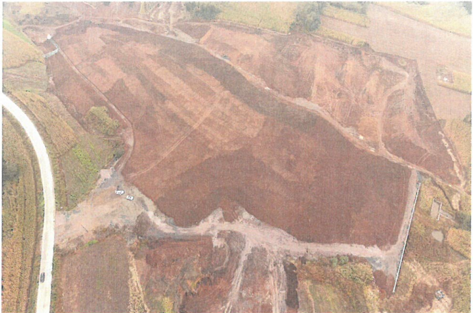
4 标 10-2 弃渣场覆土及挡墙
