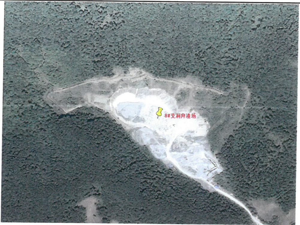
吉林干线 8#支洞弃渣场 2017 年 6 月遥感影像 (占地面积 6.75hm 2 )
