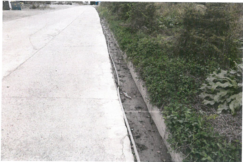
3 标 6#支洞工区排水沟
