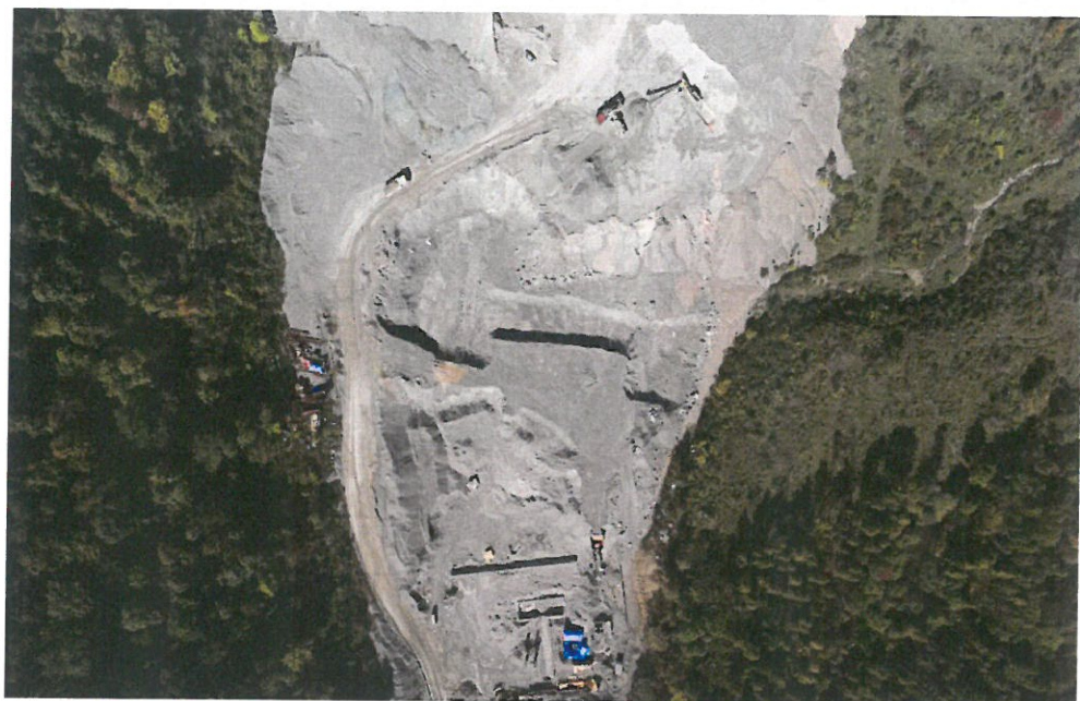
2017 年 9 月 8#支洞弃渣场无人机监测
