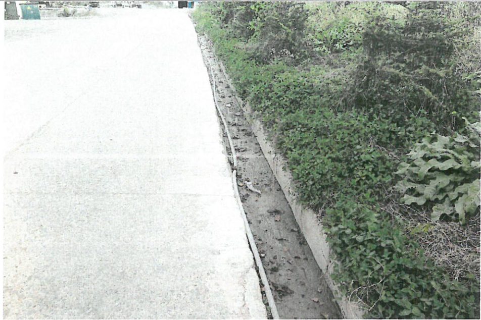
3 标 6#支洞工区排水沟
