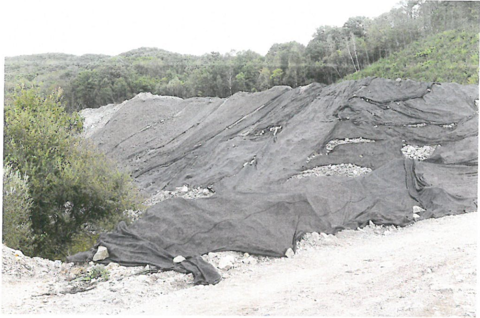
3 标 5#支洞弃渣场密目网临时苫盖
