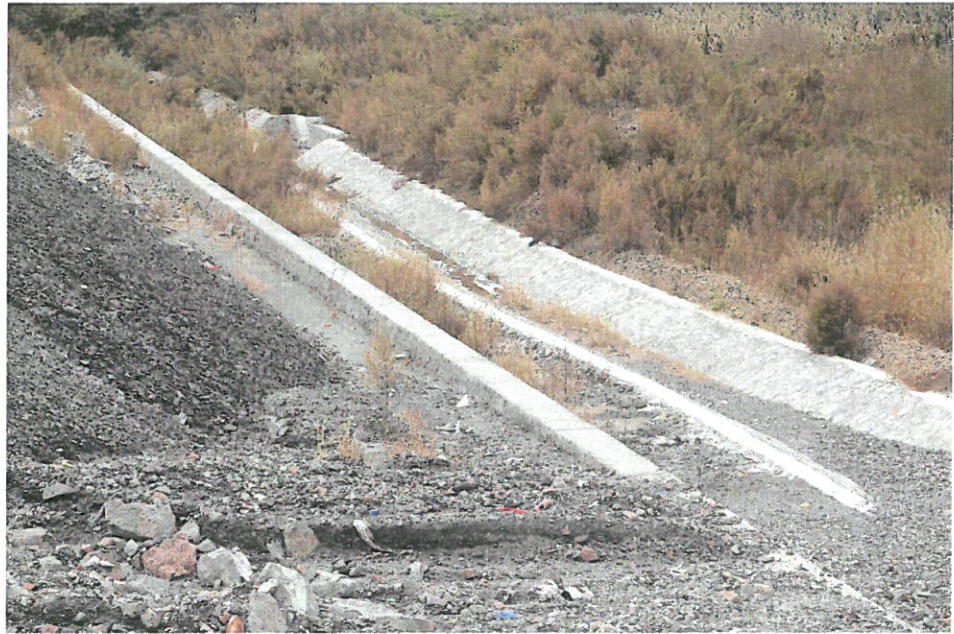
3 标 6#支洞排水沟及挡墙
