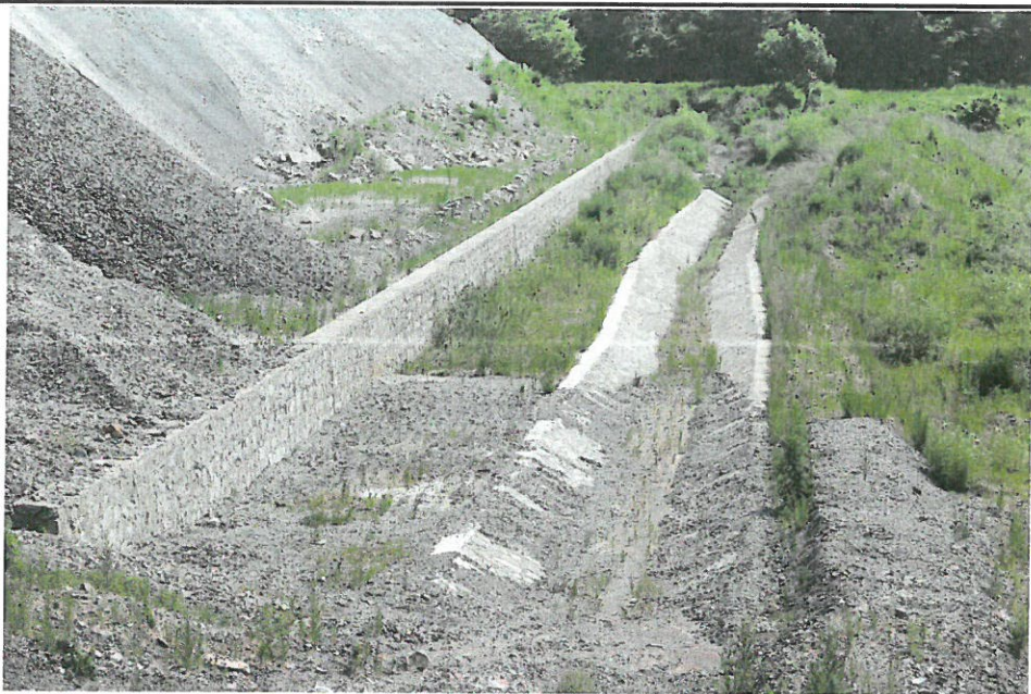
总干 6 号支洞永久弃渣场挡渣墙及排水沟
