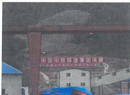
隧洞口上方有大量弃渣，建议相关单位及时清理。
